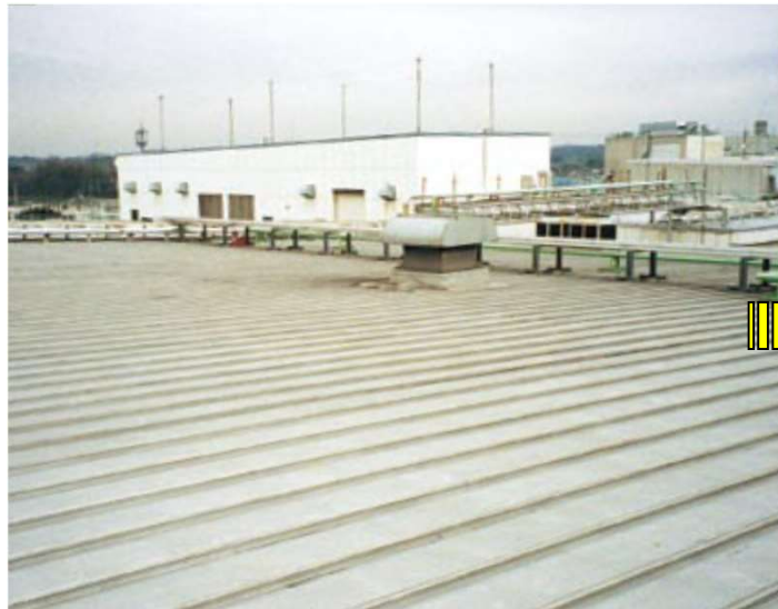
既存瓦棒葺き屋根
