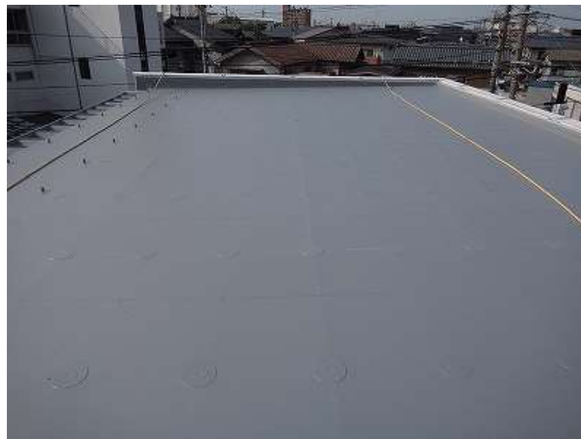
防水シート敷き込み完了
