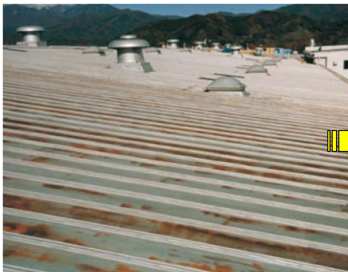
既存折板屋根
