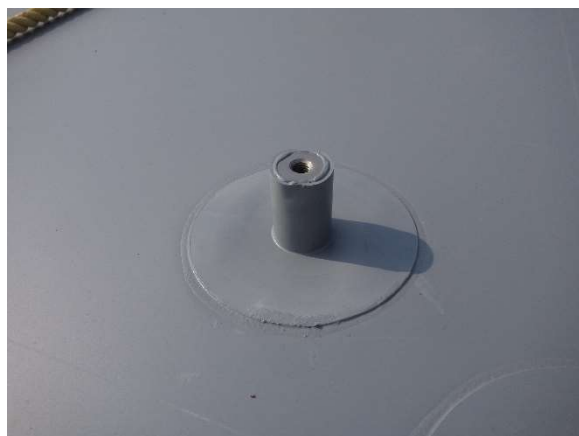
防水完了後の状態
