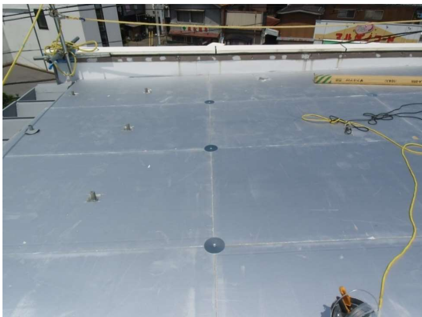
断熱材敷き込み・防水固定金具
