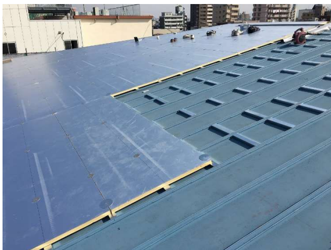
③断熱材 敷き込み
