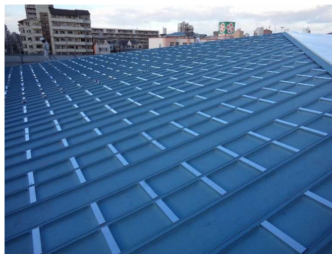
②専用金具 配置・取付け
