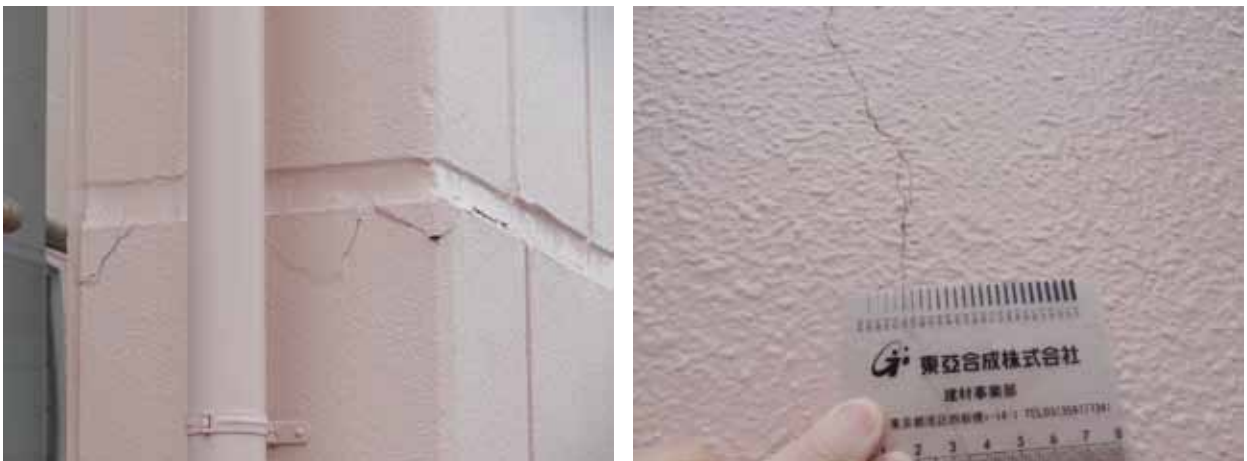
写真14 商業施設 [RC造・鉄骨造ALCパネル張り, クリスタルウォール, 施工後1年経過]
