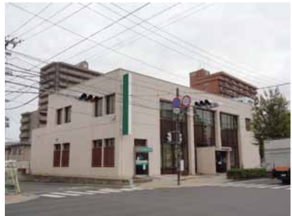
写真 5 商業施設 [RC 造, 1983 年竣工, アロンウオール ST 工法, 施工後 16 年経過]
