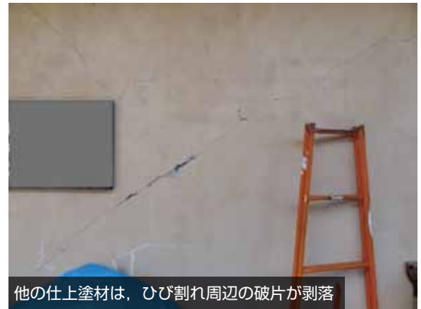
写真7 宿泊施設 [RC 造, 1975 年竣工, アロンウォール ST 工法, 施工後 26 年経過]
