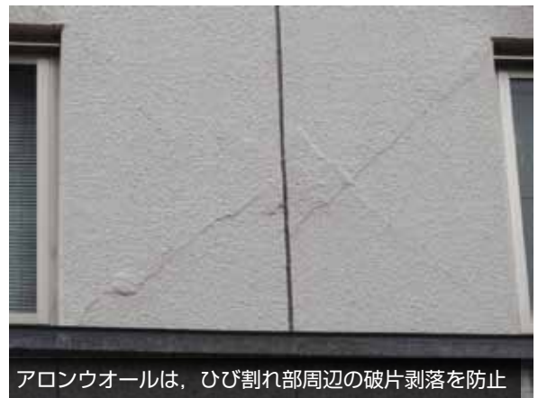
写真7 宿泊施設 [RC 造, 1975 年竣工, アロンウォール ST 工法, 施工後 26 年経過]
