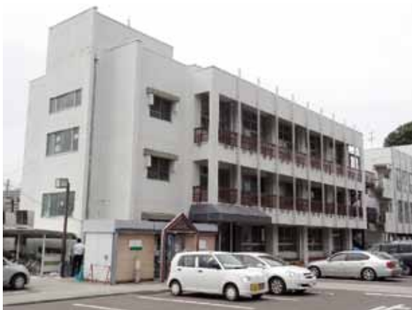
写真 4 官庁施設 [RC 造, 1976 年竣工, アロンウオール ST 工法, 施工後 17 年経過]
