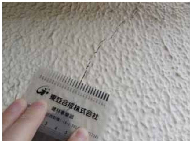
写真10 商業施設 [RC 造, 1971 年竣工, アロンウオール STM 工法, 施工後 27 年経過]
