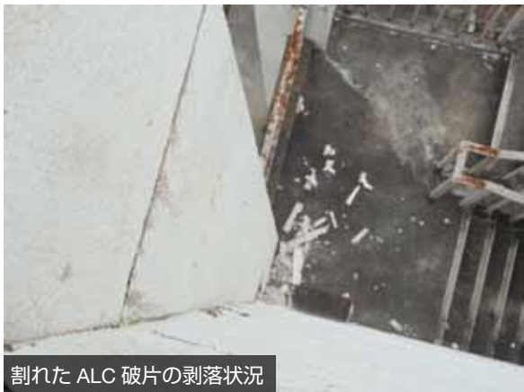
写真 12 官庁施設の被災状況 [鉄骨 ALC パネル張り]
