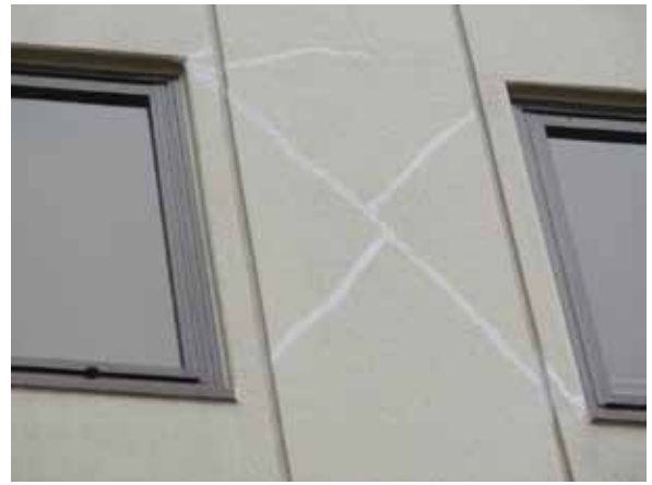
写真6 商業施設 [RC 造, 1971 年竣工, アロンウォール ST 工法, 施工後 21 年経過]
