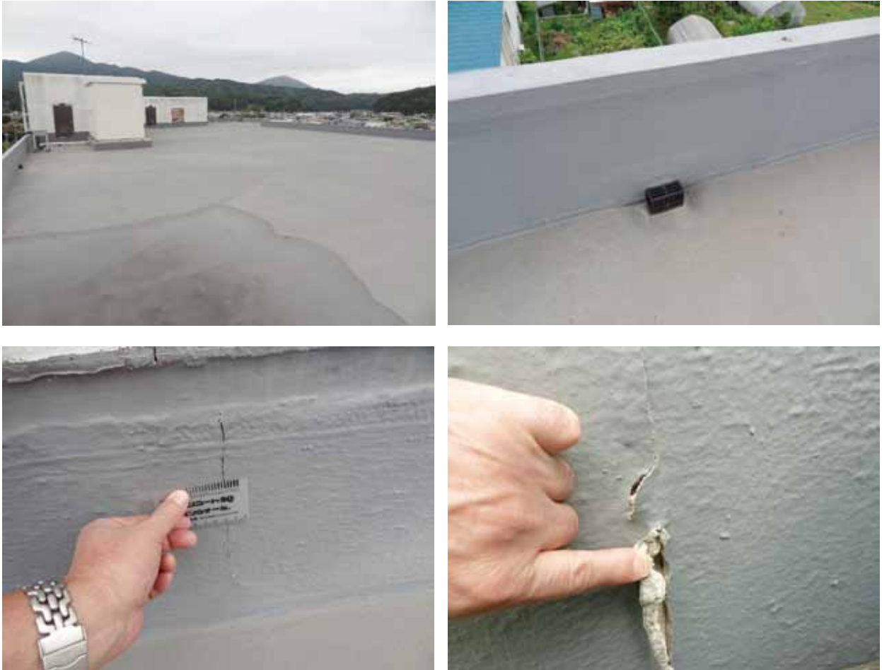
写真13 官庁施設 [写真12と同じ建屋の屋上, アロンコートSQ SQ-TK (露出通気緩衝工法), 施工後1年経過]
