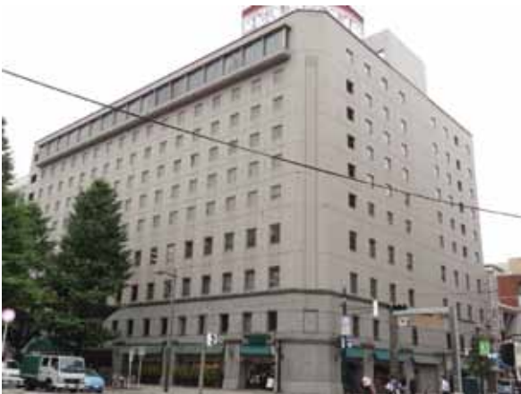
写真7 宿泊施設 [RC 造, 1975 年竣工, アロンウォール ST 工法, 施工後 26 年経過]
