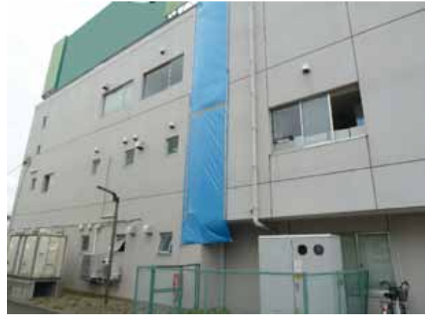
写真 3 商業施設 [RC 造, アロンウオール ST 工法, 施工後 13 年経過]
