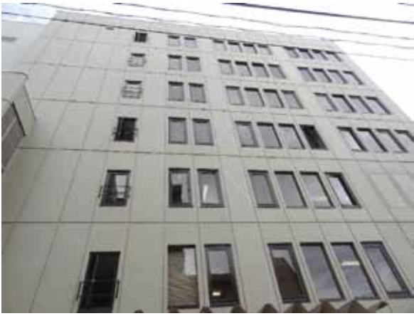
写真6 商業施設 [RC 造, 1971 年竣工, アロンウォール ST 工法, 施工後 21 年経過]
