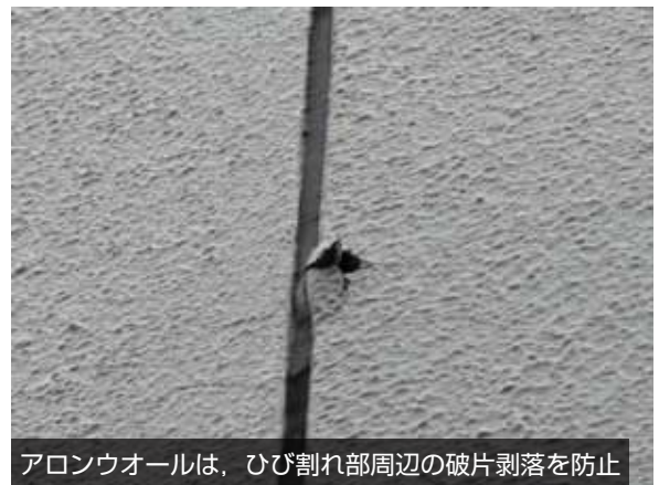
写真8 商業施設 [RC 造, 1968 年竣工, アロンウォール ST 工法, 施工後 30 年経過 (20 年前にリフレッシュ)]
