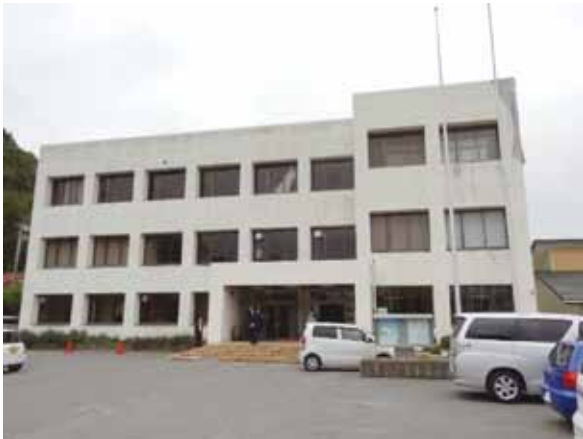
写真 11 官庁施設 [RC 造, 1992 年竣工, アロンコート SQ SQ-S (露出密着工法), 施工後 1 年経過]
