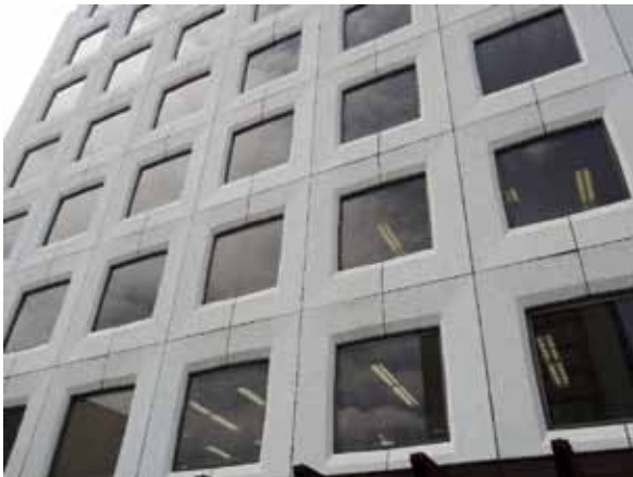
写真7 宿泊施設 [RC 造, 1975 年竣工, アロンウォール ST 工法, 施工後 26 年経過]
