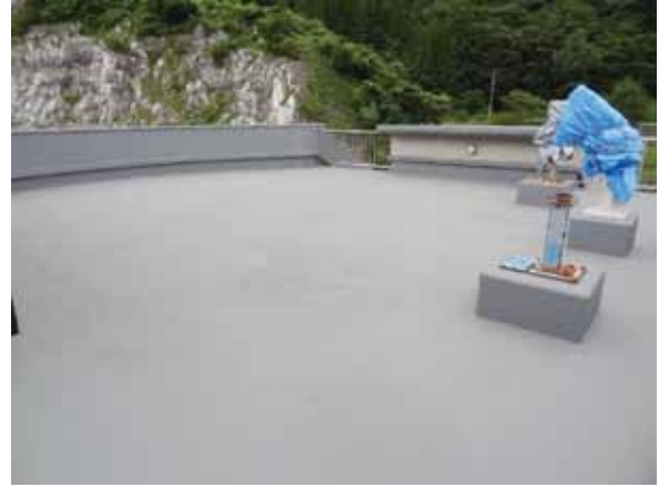
写真 11 官庁施設 [RC 造, 1992 年竣工, アロンコート SQ SQ-S (露出密着工法), 施工後 1 年経過]
