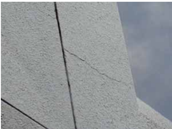
写真8 商業施設 [RC 造, 1968 年竣工, アロンウォール ST 工法, 施工後 30 年経過 (20 年前にリフレッシュ)]
