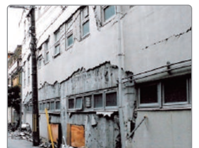
一般的な外壁の状況
