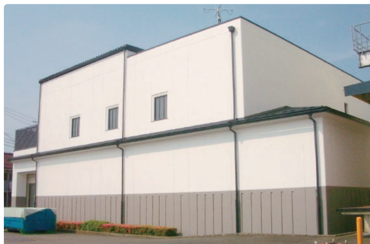
岩崎倉庫(株)米トランクルーム ▶ (東京都)
