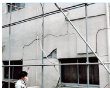
アロンウオール塗布外壁の状況
