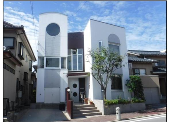
【施工後】外壁塗装工事(アロンウオールSTMローラー工法)
