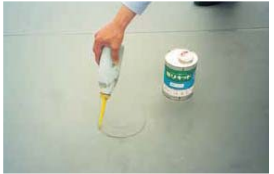
IBリキッド塗布 ●IBシートジョイント部全線に塗布
