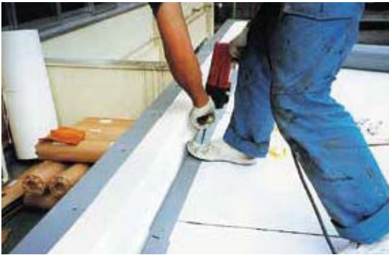
IB積層鋼板取付け ●防水端末部( #21, #42) ●立上り入隅( #10, #13, #12, #16)
