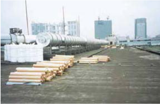
施工準備 〈サンタックIB材料荷姿〉 ●サンタックIBシート ●IB積層鋼板 ●副資材
