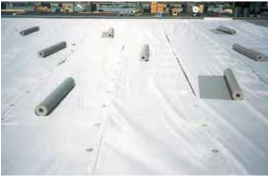
IBディスク鋼板取付け ●600ミリピッチ(標準) ●NHD工法は、300ミリピッチ(標準) ●HP工法は、平場部 #70鋼板
