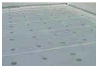
▲IHディスク鋼板の取り付け
