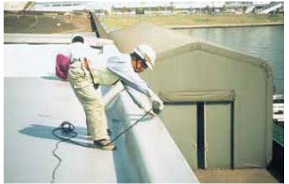
立上りシートの張付け ●端末部鋼板 #21
