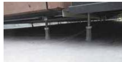
12 部材接合箇所
