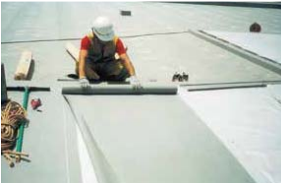
IBシート張付け ●IBシートを割付け、平場のディスク鋼板に溶着する。 ●IBシートの引張り率は、最大0.2%未満としてください。過度の引張りは、性能に影響します。(外気温等により初期にシワが発生する事があります。)
