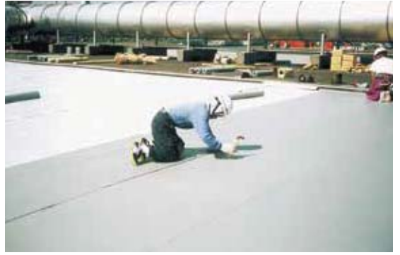
IBシートの接合 ●溶剤溶着(IB溶着剤) ●熱風融着(熱風機)
