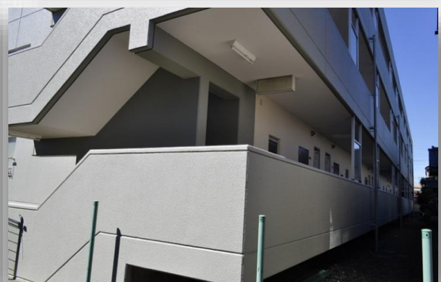
▲吹付け面／防水形複層塗材
