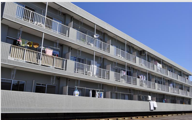
▲タイル面／剥落予防工法クリアオール
