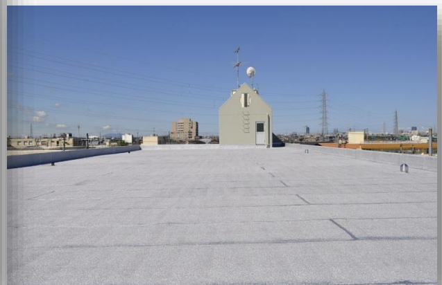
▲屋上／改質アスファルト防水クロスオーバー工法
