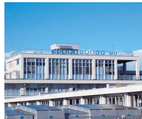
東京都水道局 東村山浄水場
