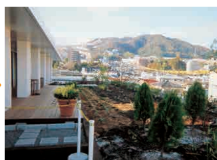
植栽施工完了
