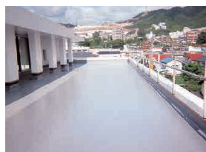
防水施工完了
