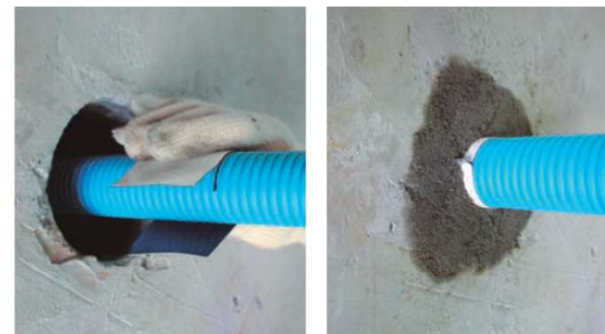
巻き付けるだけで簡単に施工できる テープ形状の区画貫通部材。
