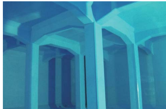
上水施設 (配水池)
