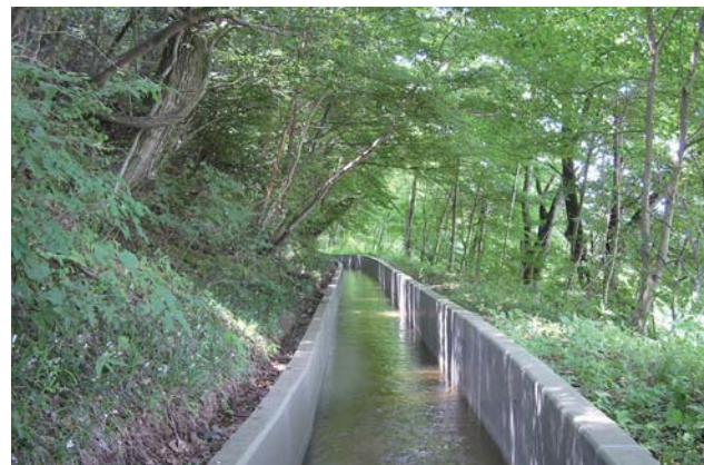
農業施設 (開水路)
