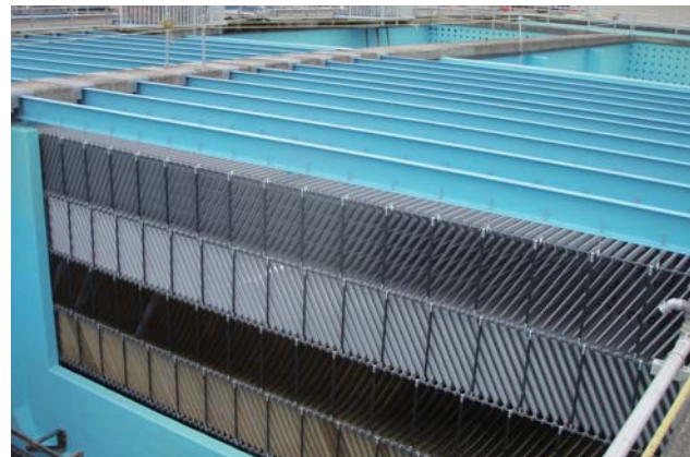
上水施設 (着水井、沈澱池)
