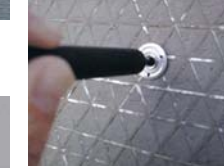
アンカーピン打込み
