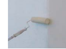
仕上げ材施工
