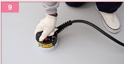
9 IHディスクの誘導加熱接合
