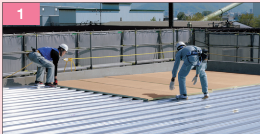
1 断熱材の敷設、断熱材目地部にAYボードテープ貼付け
