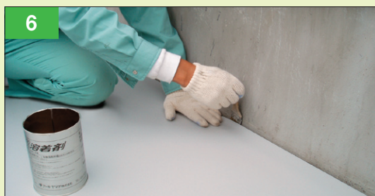
6 FL鋼板とリベットルーフの溶着接合
