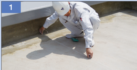
1 リベットルーフの墨出し
