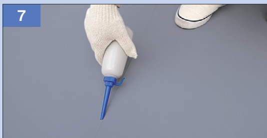
7 リベットルーフ接合端部のシール処理
