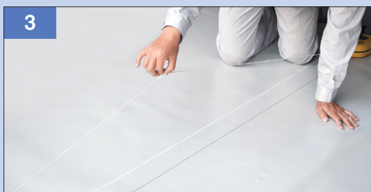
3 リベットルーフ裏面への墨出し
