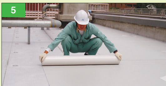
5 リベットルーフの敷設
