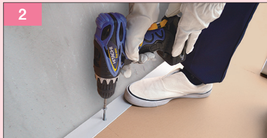
2 FL鋼板の取付け
