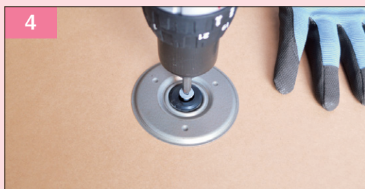
4 IH断熱ディスクの固定。固定後チューブクッションを挿入する (原則的にはその日のうちにリベットルーフを敷設できる範囲にすること)
