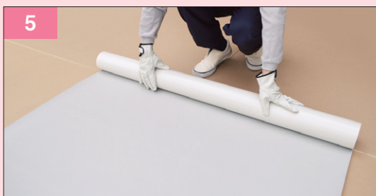
5 リベットルーフの敷設
