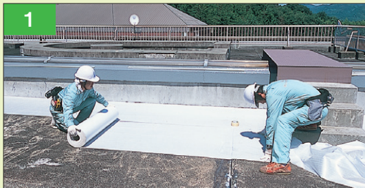
1 絶縁シートの敷き込み（新築工事では省略可）
