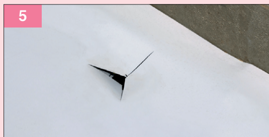
5 リベットルーフの敷設
