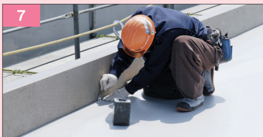
7 FL鋼板とリベットルーフの溶着接合
