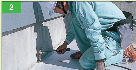
2 FL鋼板の取付け
