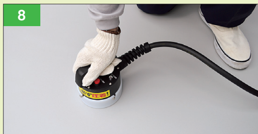
8 リベットルーフとIHディスクの誘導加熱接合
