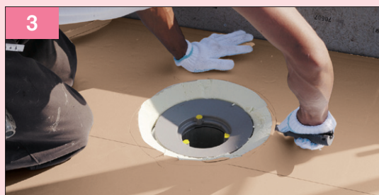
3 周辺断熱材の勾配調整
