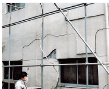
アロンウオール塗布外壁の状況
