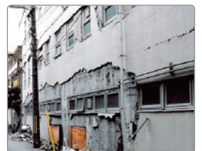
一般的な外壁の状況
